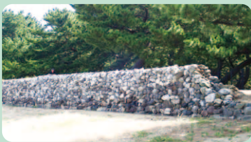
生の松原地区の元寇防壁
